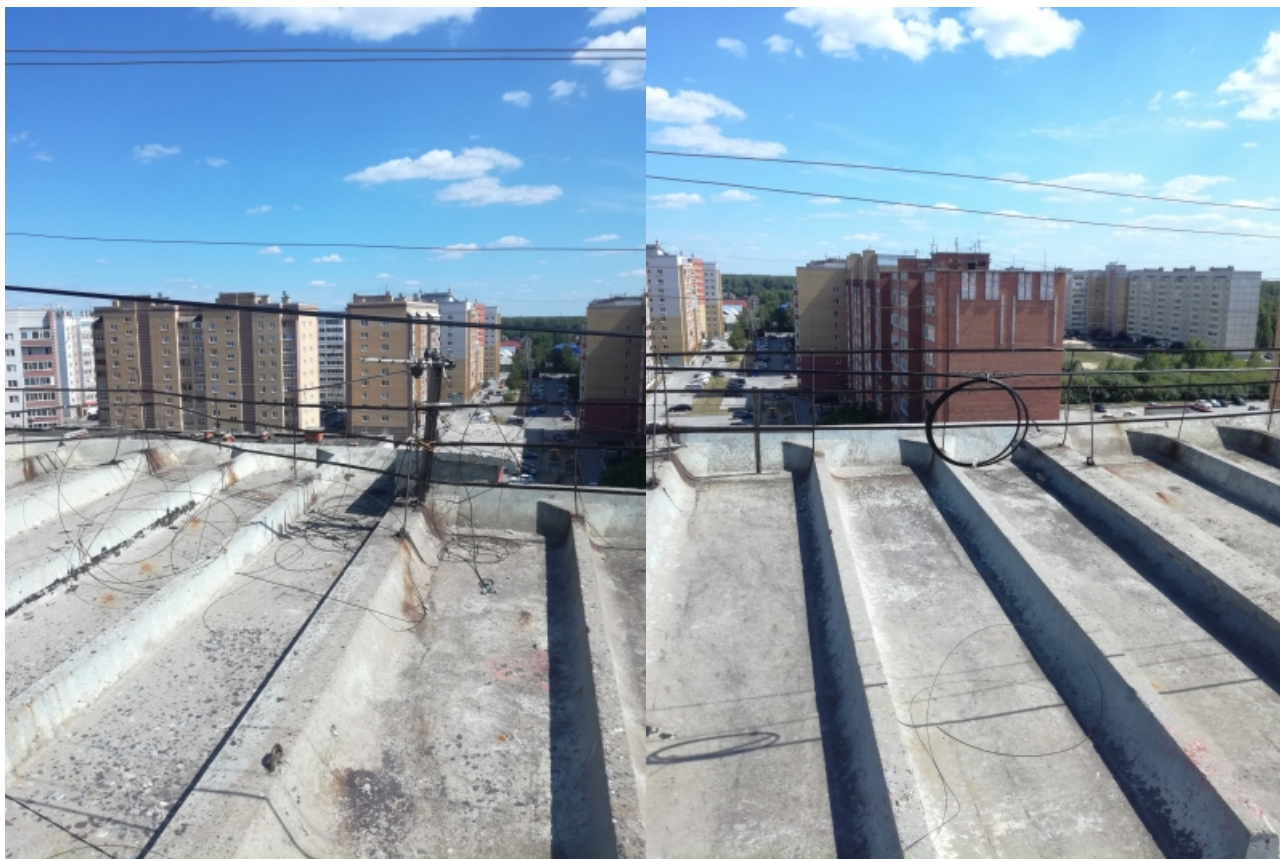
[Монтажные будни и развлечения]
