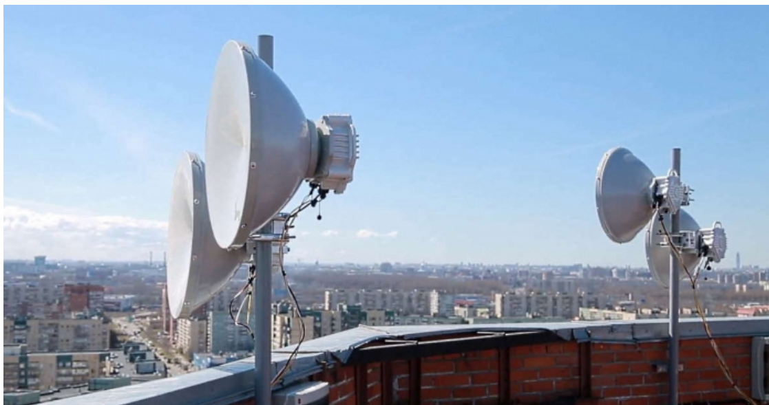
На фото 10-гигабитные РРЛ компании ДОК (Санкт-Петербург). Источник: ДОК
