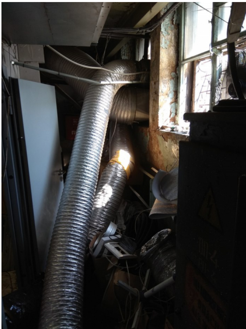
Приточная вентиляция. Начало.
