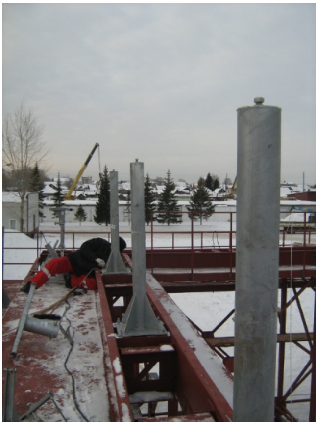
Трубостойки на помосте
