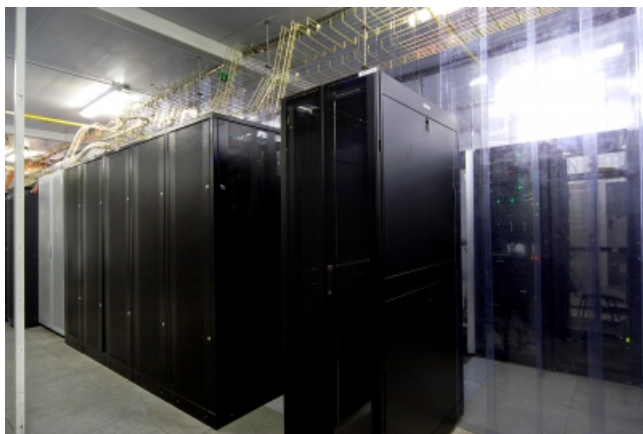
Холодный коридор отгорожен пластиком
