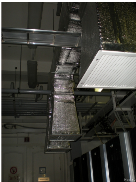
Система воздушного охлаждения - поддерживает температуру в 21 градус по Цельсию: очень сильный звук от ее вентиляторов, долго в зале находиться нереально - просто заболит голова
