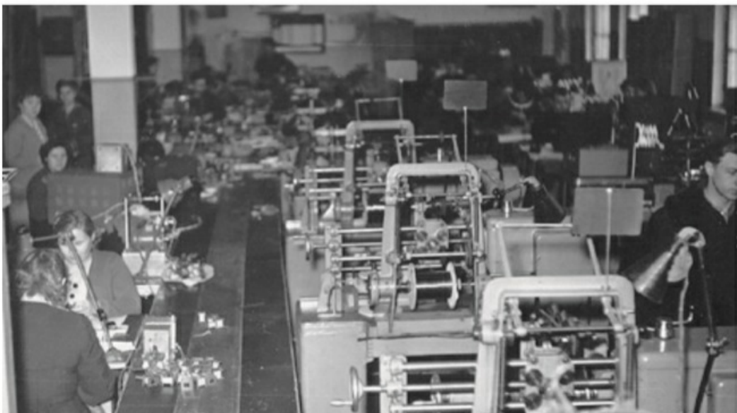
Участки намотки катушек крупногабаритных трансформаторов цеха 6, 1961 г.
