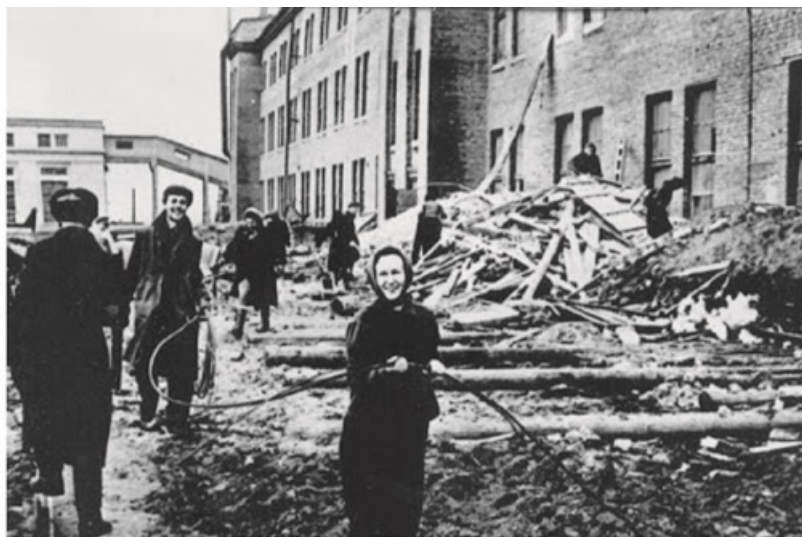
Субботник на строительстве корпуса вспомогательных цехов
