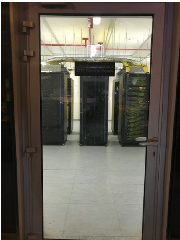
Коммуникационный зал жилого дома, вид с улицы
