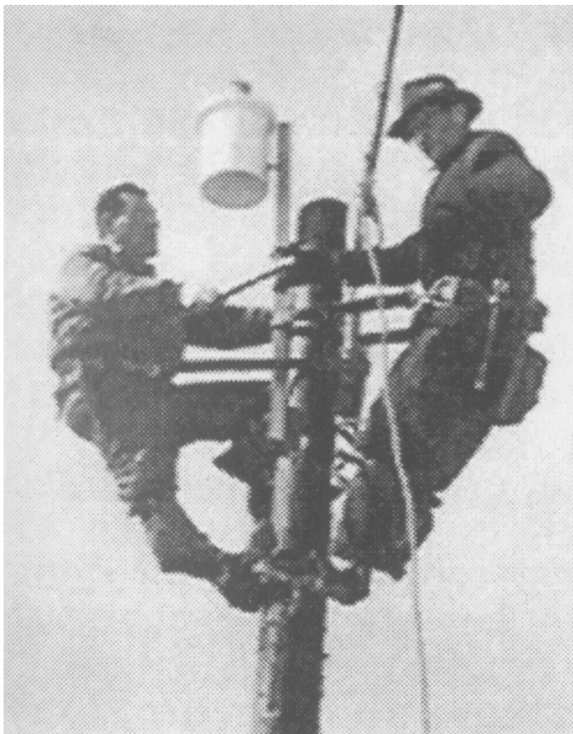
Монтажники устанавливают цилиндры на телеграфных столбах
