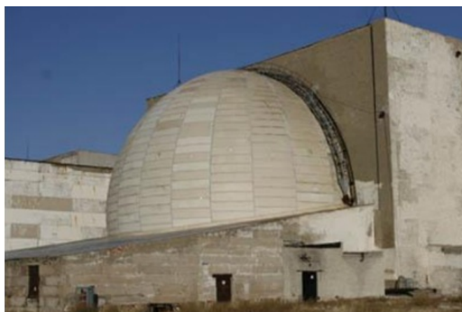
Рис. 6 – Приемная позиция РЛС "Неман" на Балхашском полигоне
