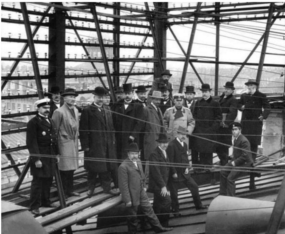
Этот снимок сделан в Петербурге, 1 июля 1882 года, на крыше дома № 26 по Невскому проспекту. Сняты на нем сотрудники фирмы Белл, которые только что запустили в эксплуатацию первую в России телефонную станцию. О том, что кабель придётся прокладывать под землёй пока ещё никто даже не думал
