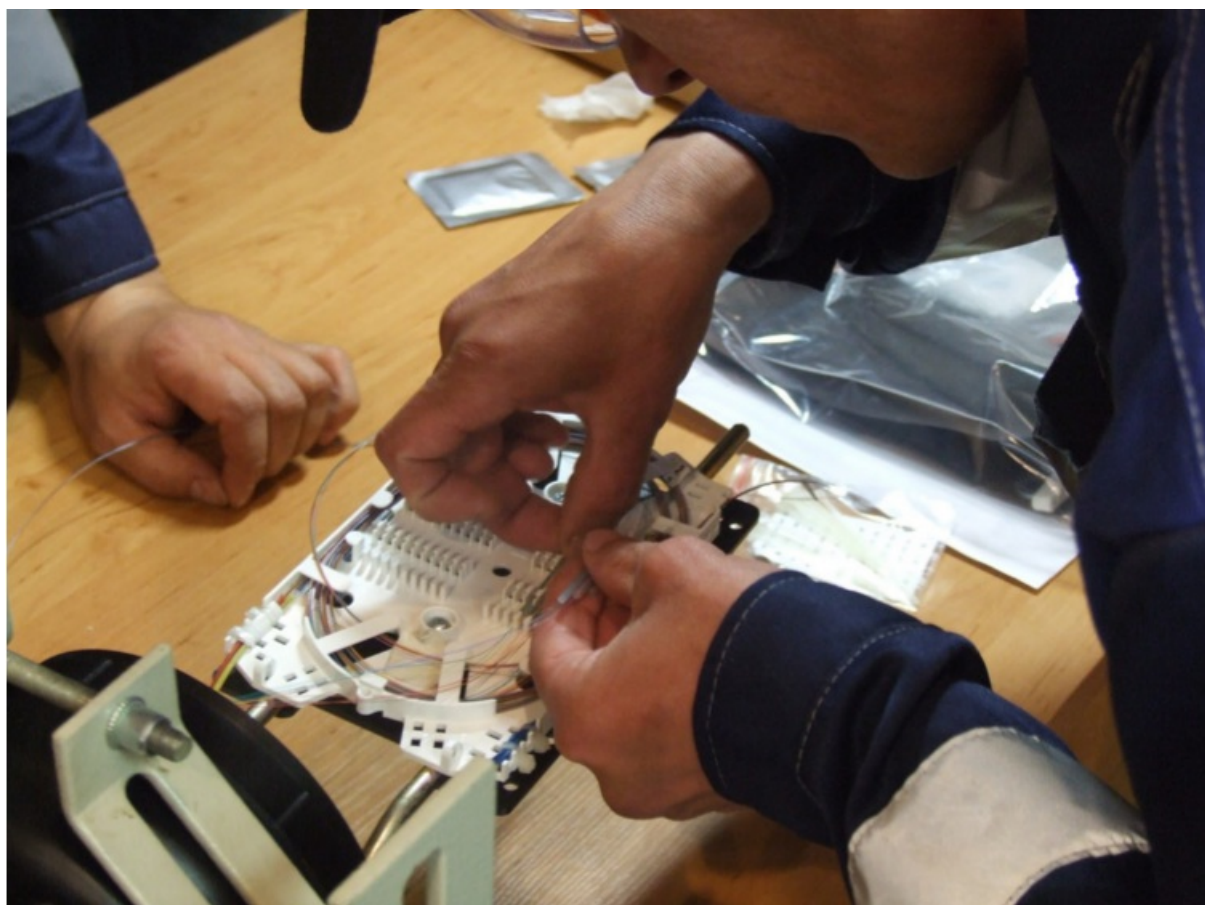
После совершения всех этих манипуляций, муфту герметизируют с помощью термоусадочной трубки.
