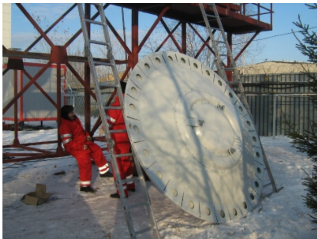
Перекур перед подъемом
