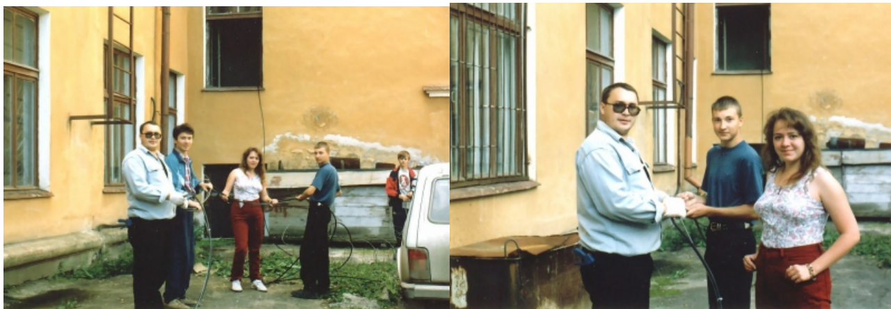
Крепление кабеля к проволоке, первые метры. Фотографии 1998 года.
