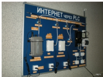
Стенд с PLC-оборудованием – головная станция и модемы от Corinex
