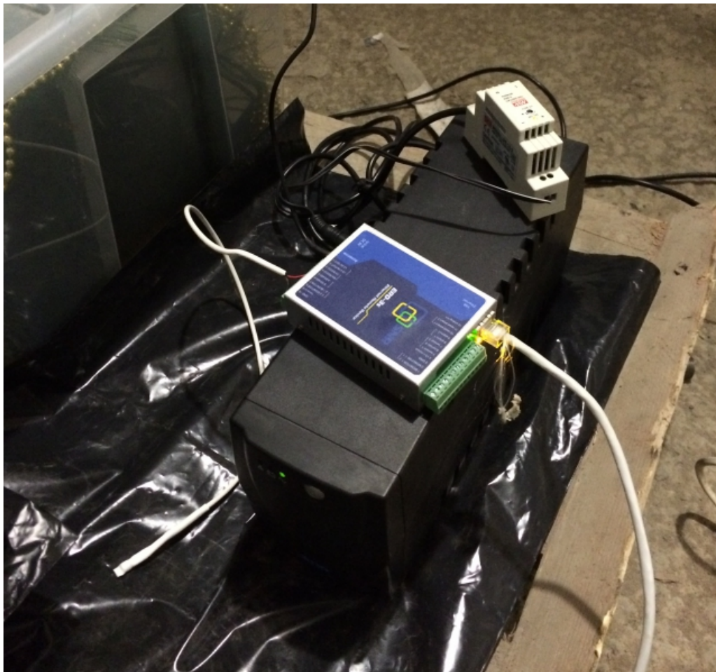
Готовим ИБП и ERD к тестированию
