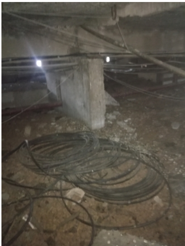
[Монтажные будни этой весны]
