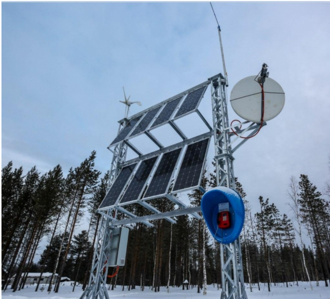
Ростелеком запустил автономный таксофон в северном селе без электричества
