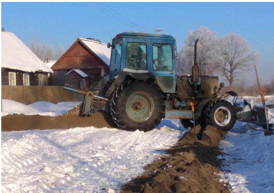
Прокладка волоконно-оптического кабеля к избирательному участку
