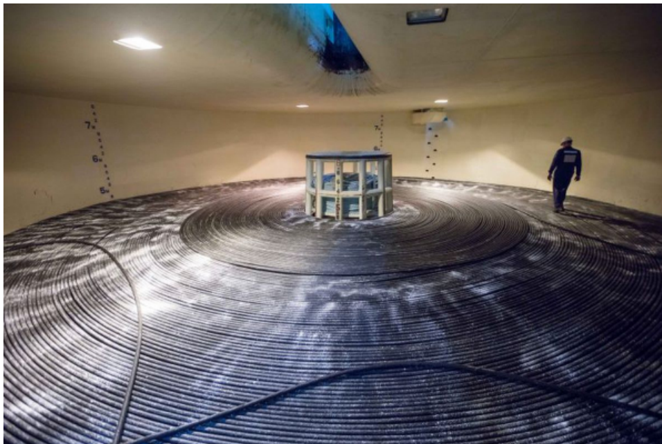
Смотанный кабель Marea в трюме судна-кабелеукладчика
