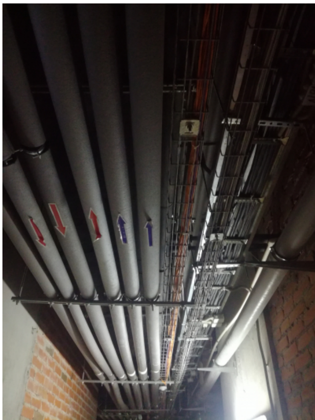
[Подвал современного дома]
