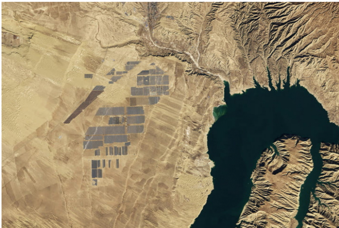
Солнечная электростанция Лунъянся (Longyangxia Dam Solar Park). Местонахождение: Тибетское нагорье, Китай. Площадь объекта: около 30 кв. км. Мощность генерации - 850 МВт.
