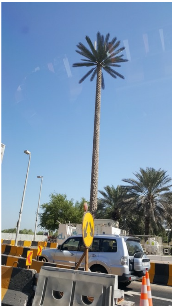
Базовая станция оператора Du в виде пальмы
