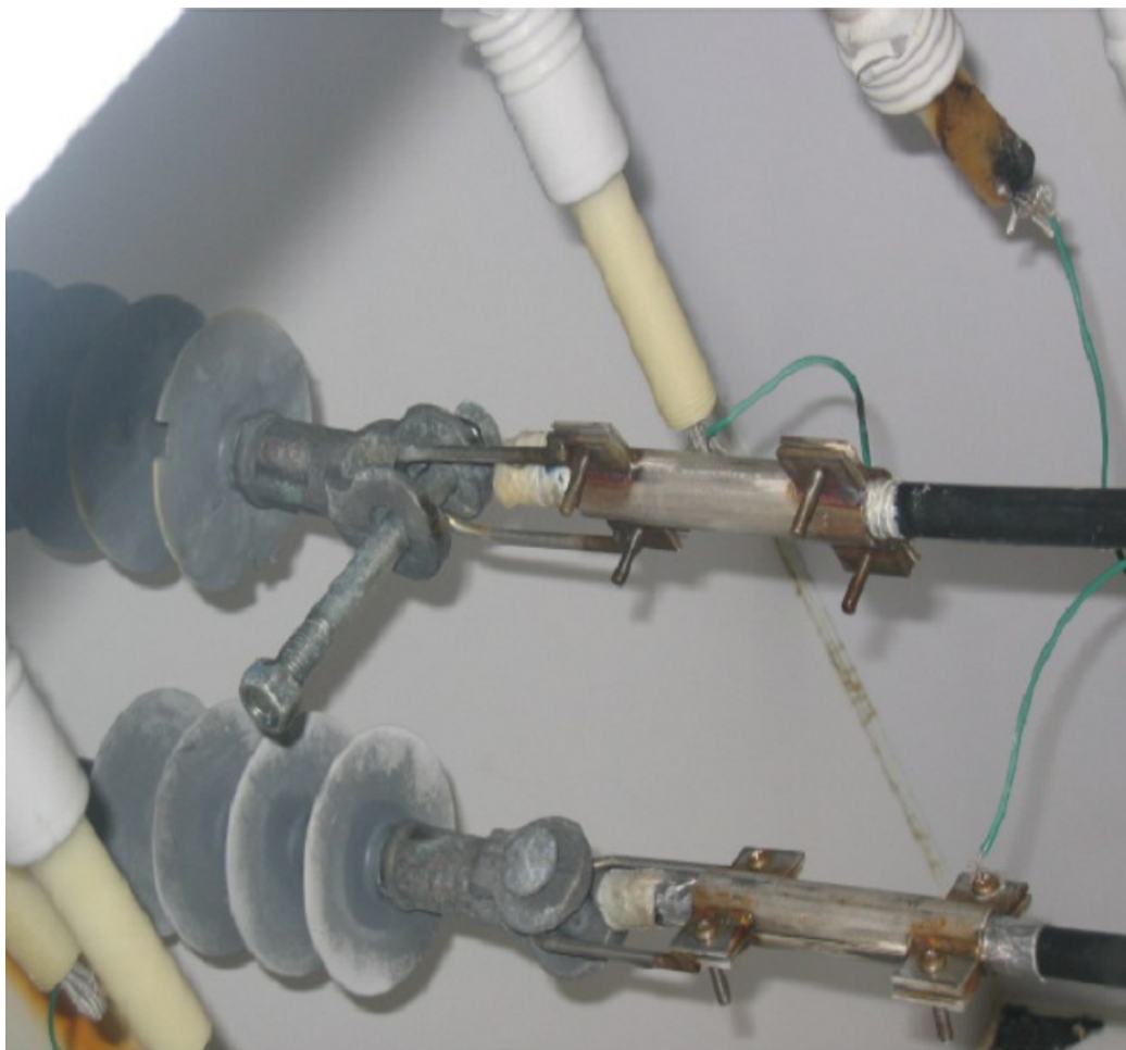
Рис.12а Подвесные полимерные изоляторы на стороне А
