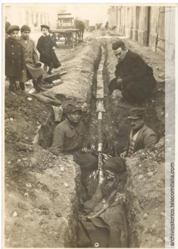
Posa del cavo lioure-toscano, 1928
