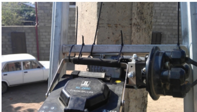
Разварка муфты с лестницы на высоте.
