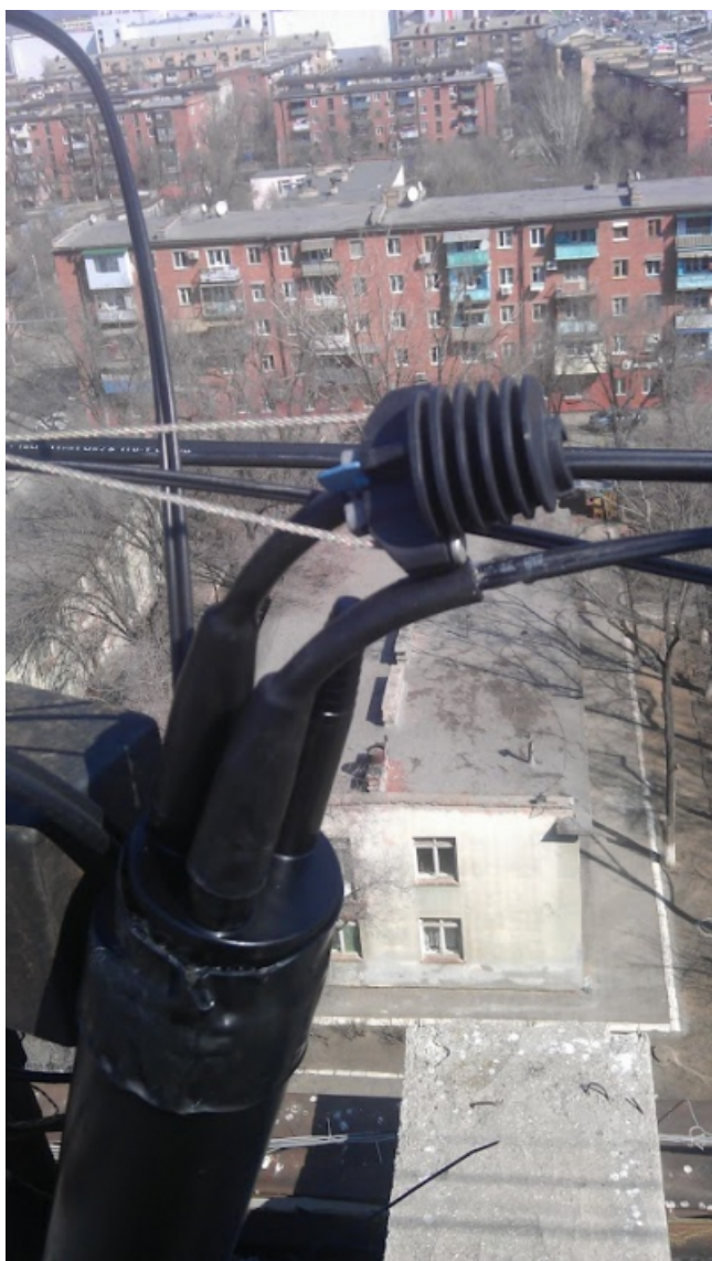
Оптическая муфта заканчивается подвесом.
