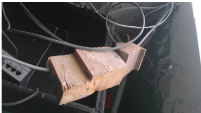
Методика ввода кабелей через деревянную раму. =)
