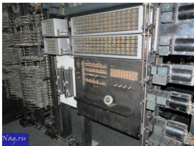
Детали АТС поближе - слева искатели АТС машинной системы, справа - регистр-пересчетчик
