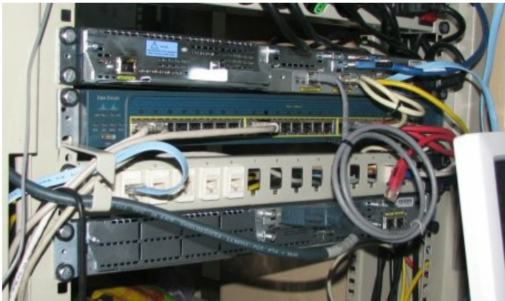
рис. 4. Патч-панель после установки.
